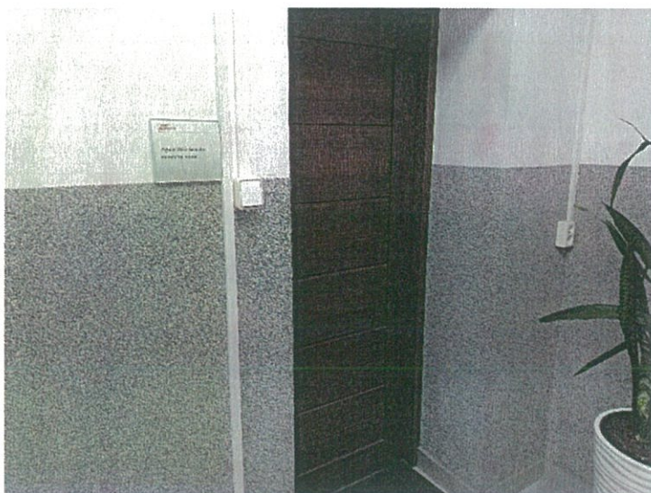
Zdjęcie nr 20 – istniejące drzwi w korytarzu Budynku Administracyjnego przeznaczone do wykucia. Należy zamontować w to miejsce drzwi akustyczne 42 dB. Zamawiający zaplanował wymianę trojga drzwi na drzwi dźwiękochłonne.
