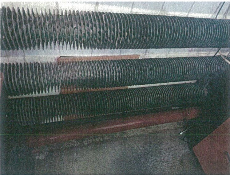
Zdjęcie nr 3 – fragment rury stalowej poziomu c.o. – zaplanowano wykonanie ocieplenia odkrytej części rury instalacji c.o.
